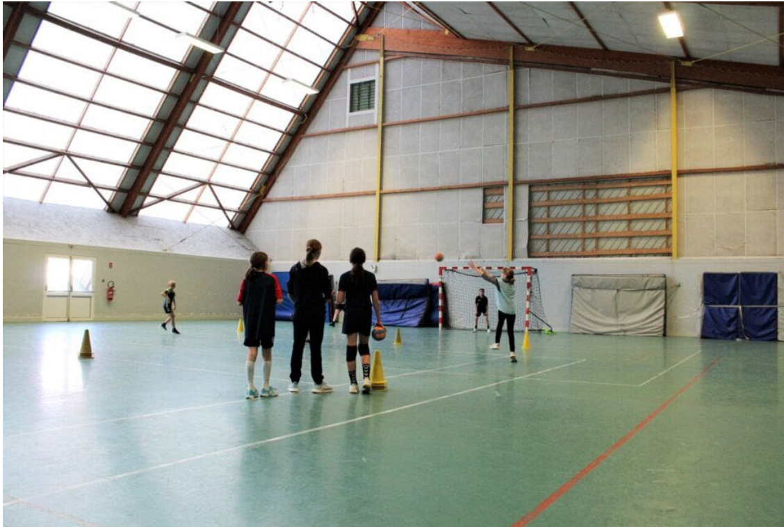
Trame oblique en polycarbonate Gymnase de Manneville-sur-Risle
