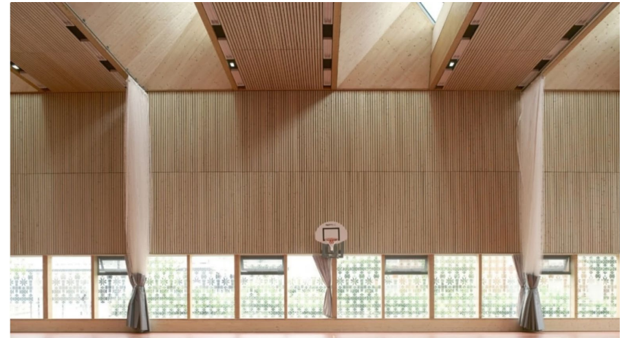
Gymnase Alice Milliat - 2016, 7e arrondissement de Lyon Ossature bois avec une isolation en bottes de paille
