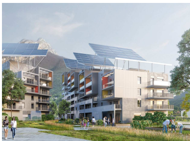
Construction neuve ABC sur la presqu'île de Grenoble (source : Valode et Pistre Architectes, Bouygues Construction)
