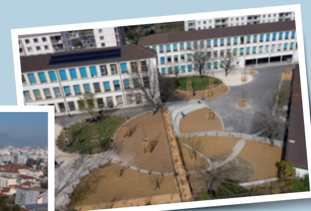
Désimperméabilisation de la cour de l'école Clémenceau et développement des places aux enfants.
