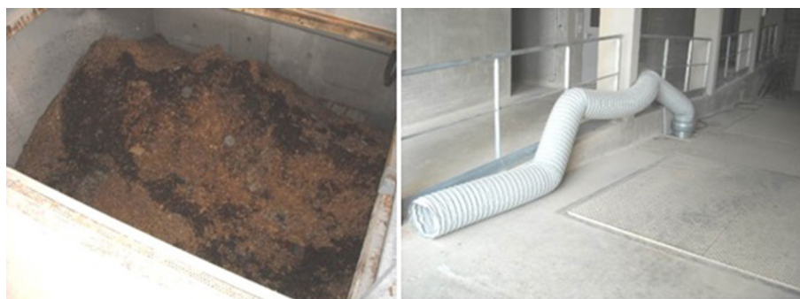
▲ Figure 45 : Silo à trappes carrossables avec une mauvaise circulation d'air
