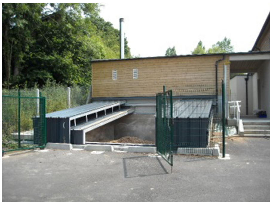
▲ Figure 12 : Exemple d'un silo enterré extérieur avec trappes coulissantes
