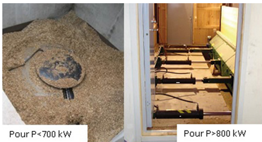
▲ Figure 14 : Exemple de systèmes de dessilage à balayage rotatif (à gauche) et à échelles racleuses (à droite)
