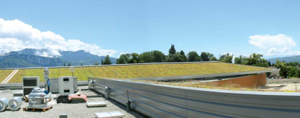
Toiture végétalisée du Centre Technique de Coublevie (38).
