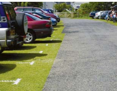
Exemple de revêtements perméables : dalles stabilisatrices de graviers (MCK Environnement).
